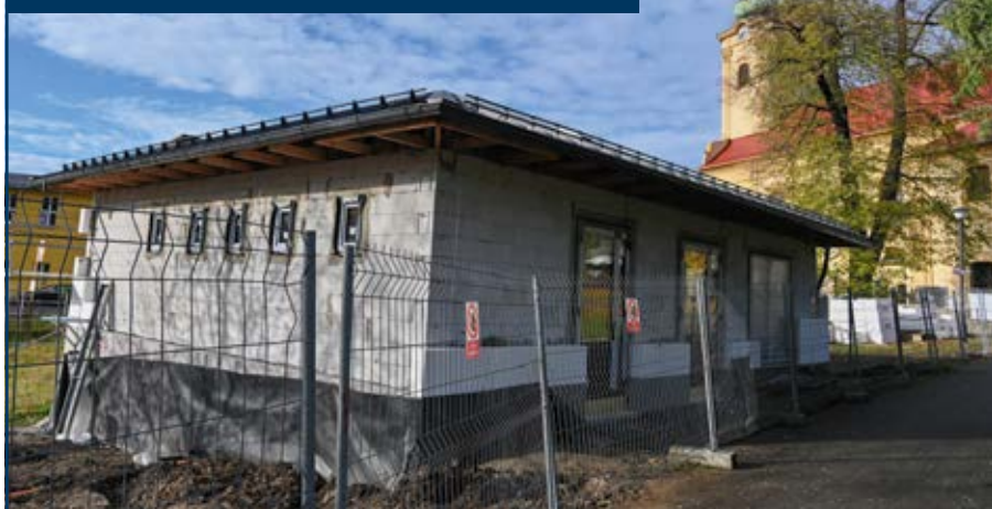
Stavba nové květinové síně na ústředním hřbitově.
